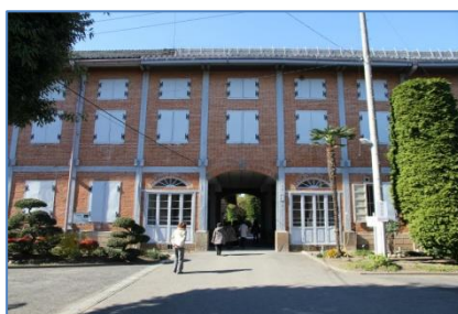
明治5年建築 長さ 104.4m 幅 12.3m 高さ 14.8m 東繭倉庫「木骨煉瓦造」重要文化財
