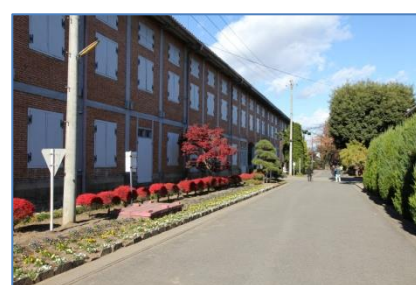
明治5年建築 長さ 104.4m 幅 12.3m 高さ 14.8m 東繭倉庫「木骨煉瓦造」重要文化財
