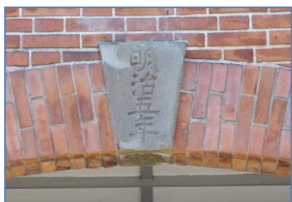
明治5年建築 長さ 104.4m 幅 12.3m 高さ 14.8m 東繭倉庫「木骨煉瓦造」重要文化財
